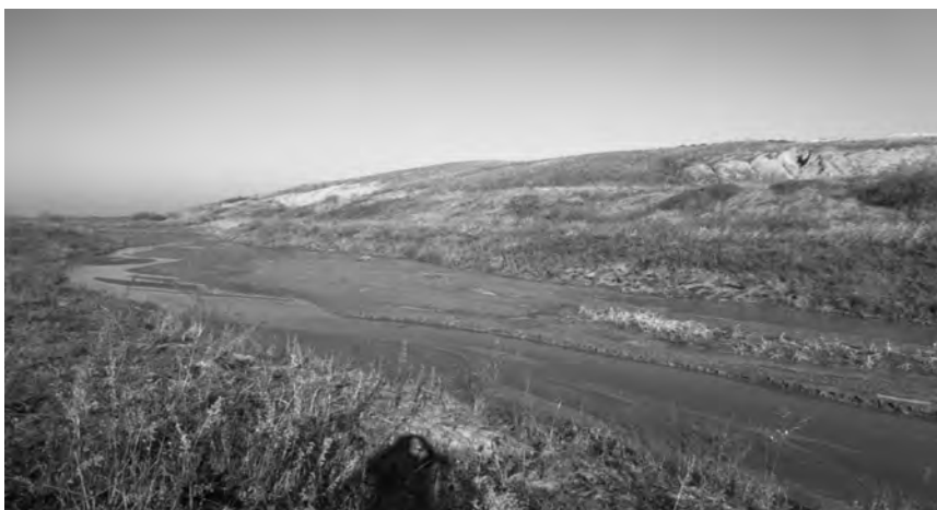
Рис. 6. Заиливание нагорной канавы № 8
