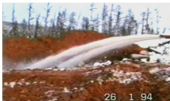
Рис. 1. При аварийном фонтанировании скважины ПВО закрыто, рапа с дебитом 5300 \text{ м}^3/\text{сут.} по выкидным линиям перепускается в аварийный амбар. Фото А.Г. Вахромеева, скважина 18 Ковыктинская, 1994 г.
