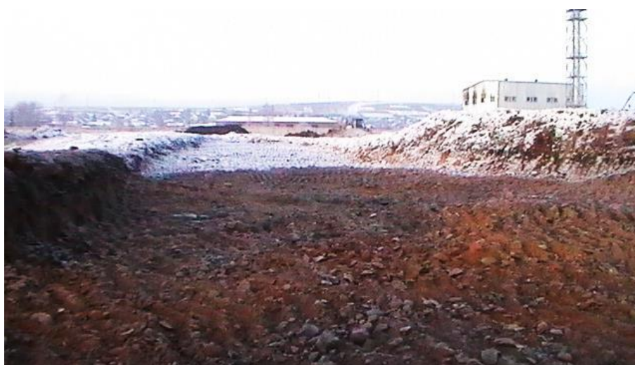
Рис. 3. Траншея выборки загрязненного почвогрунта промплощадки АМЗ
