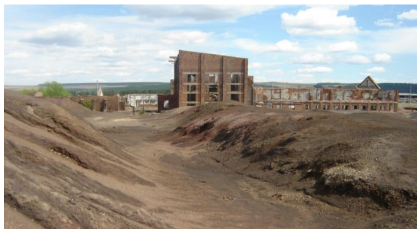
Рис. 2. Общий вид промплощадки АМЗ до начала работ по ликвидации, 2009 г.
