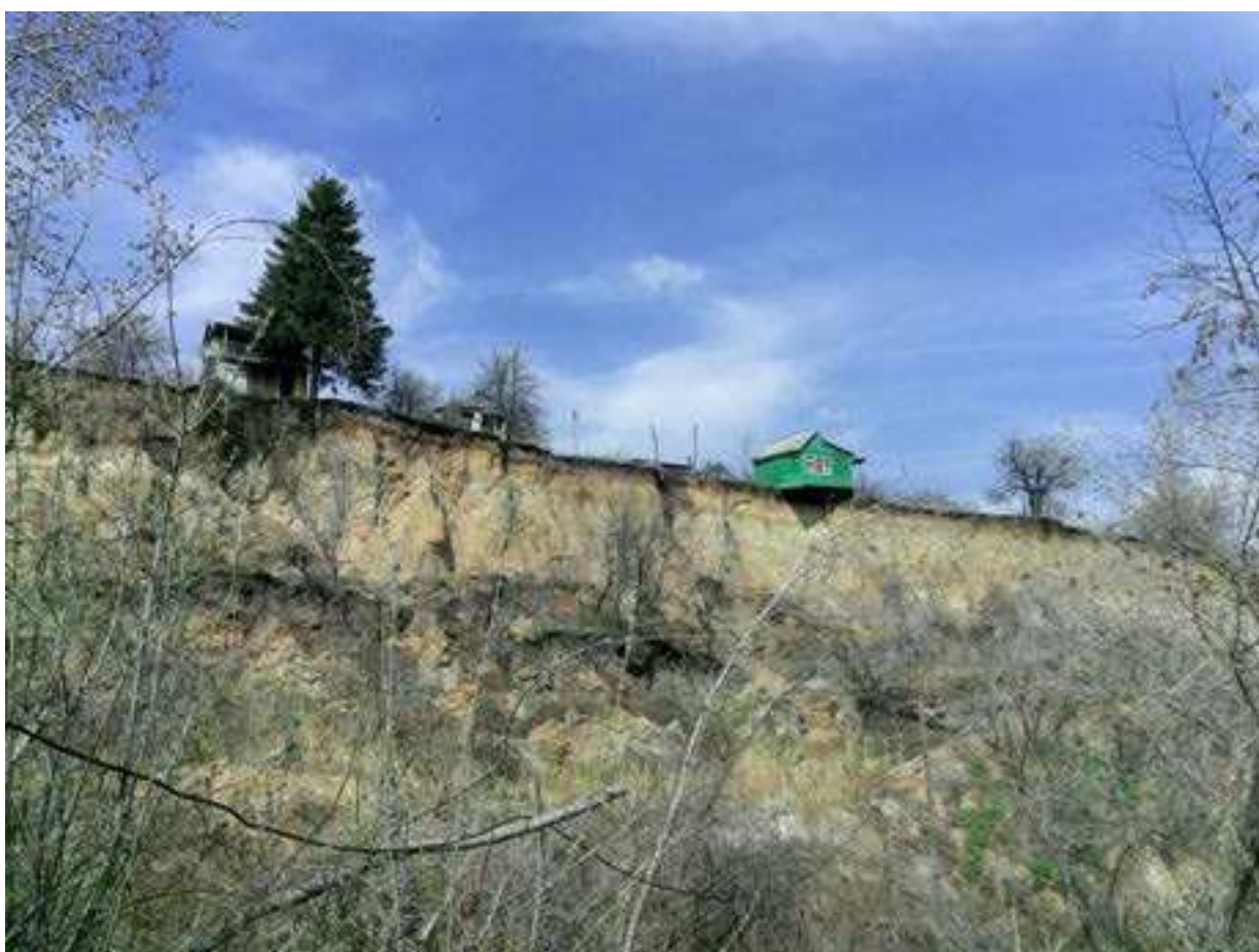
Рис. 8. Разрушающийся дачный поселок
