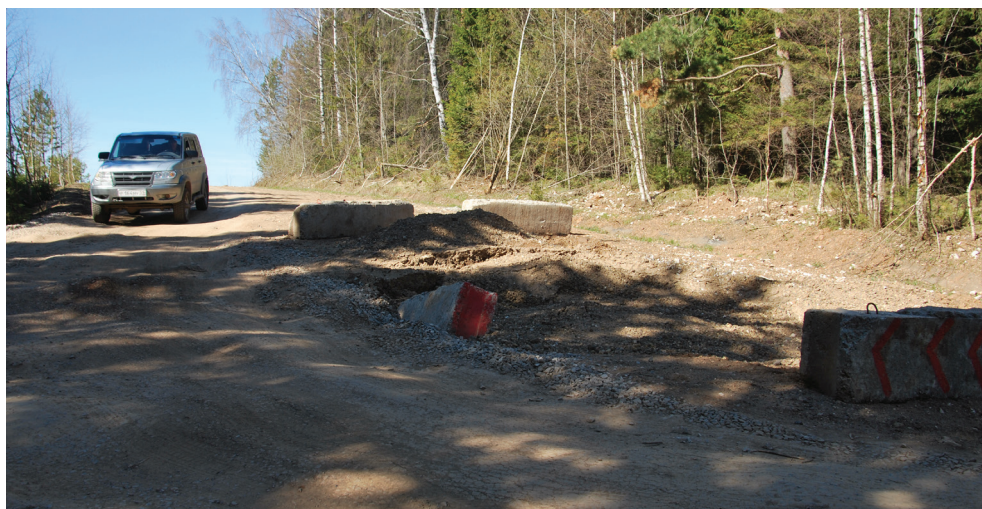
Рис. 2. Просадка на месте засыпанного провала на дороге Мостовая–Насадка (15.05.2018 г.)
