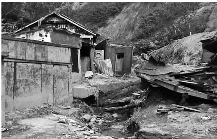
Рис. 1. Деформация гаражей селевыми и оползневыми отложениями после тайфуна «Руса», 2002 год, Ю. Сахалин. Фото Ю.В. Генсиоровского (из отчета ВСЕГИНГЕО, 2006 г.).
