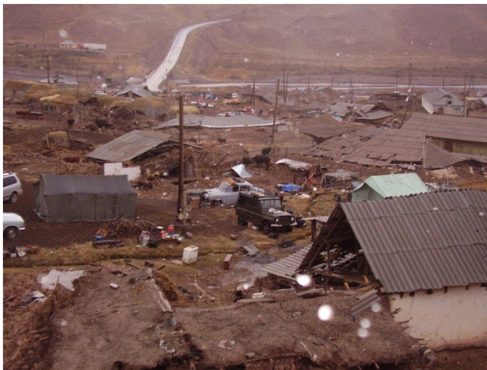
Рис. 1. Полное разрушение населённого пункта Нура впоследствии землетрясения 05.10.2008 г., K=14.8 , I_0=8 баллов (фото Омуралиева М., Ормукова Ч.).
