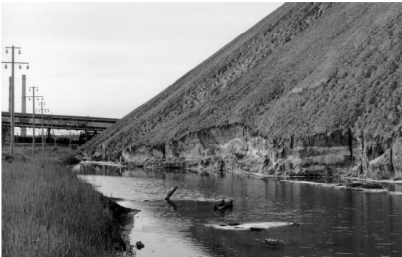
Рис. 3. Стенка обрушения по периметру отвала.
