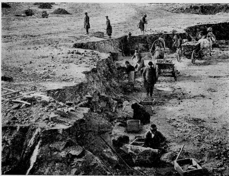
Видъ работъ на отдѣльномъ горизонтѣ разрѣза.
