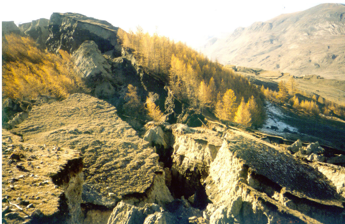
Рис.20 Трещины в теле оползня
