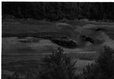
Рис. 4. Образование оврагов на втором осушенном хвостохранилище ЦОФ, г. Солнечный
