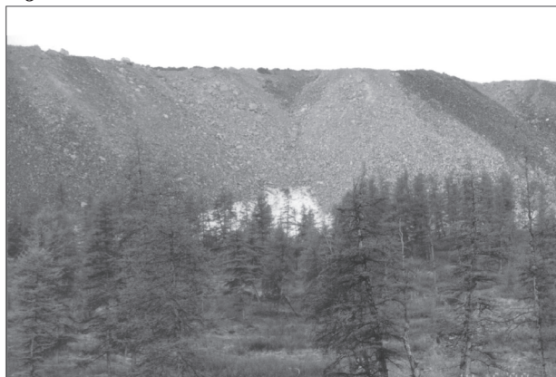
Рис. 3. Формирование ледяного цемента в нижних частях отвалов и криогенные явления в ходе промерзания на месторождении Кубака, Магаданская область: а – выступающий на поверхность слой ледяной изморози в нижней части фронтального откоса; б – пояс угнетенной вегетации в зоне влияния холодных воздушных потоков, выходящих из-под отвалов; в – формирование ледово-каменного горизонта в нижней части фронтального откоса отвала 670 полигона «Восточный»
