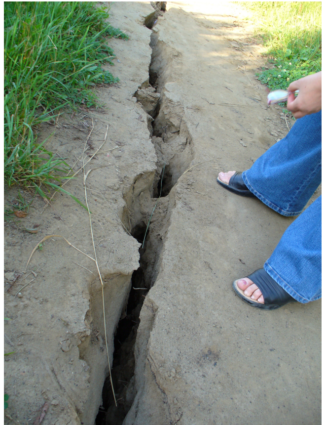
Рис. 8. Пос. Шебунино. Раскрытие трещины на берегу. Фото О.М. Шестаковой.
