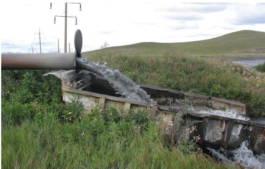
*Рис. 3. Транспортировка пульпы с ТЭЦ в гидрозолоотвал*
