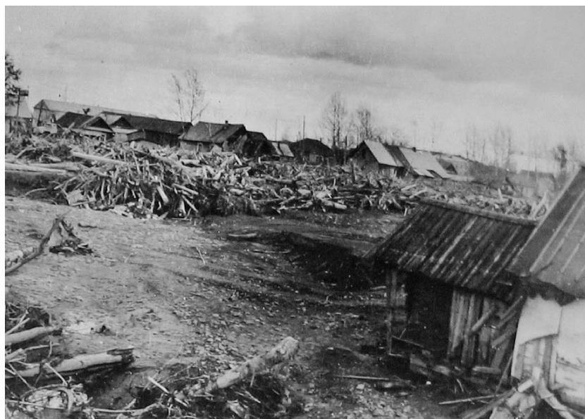
Рис. 6. Карчеход на р. Буюклинка, разрушивший п. Березняки в августе 1981 г. ниже трассы нефтегазопроводов “Сахалин-2”. Фото из фондов Сахалинского краеведческого музея.
