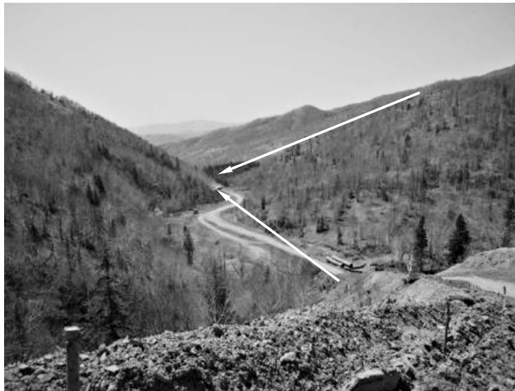
Рис. 4. Трубопроводы уложены в селевое русло (р. Пулька). Фото Генсиоровского Ю.В. (осень 2007 г.).
