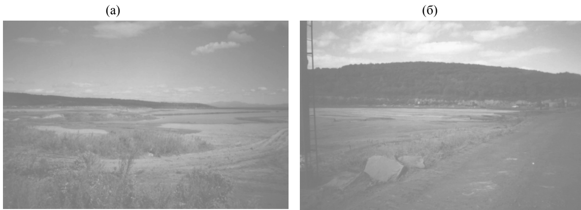
Рис. 1. Вид золоотвала: (а) – секция № 1, (б) – секция № 2.
