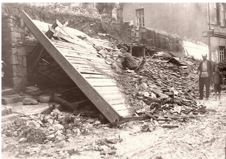
Последствия крымского землетрясения 1927 г.
