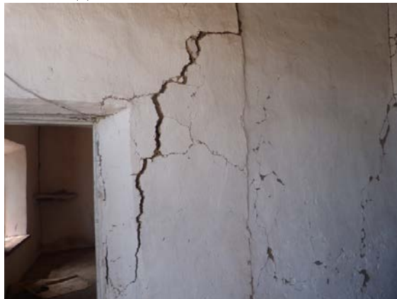
Фото 9-10. Кишлак Дувана (Таджикистан): сквозные трещины на стенах глинобитных домов.
