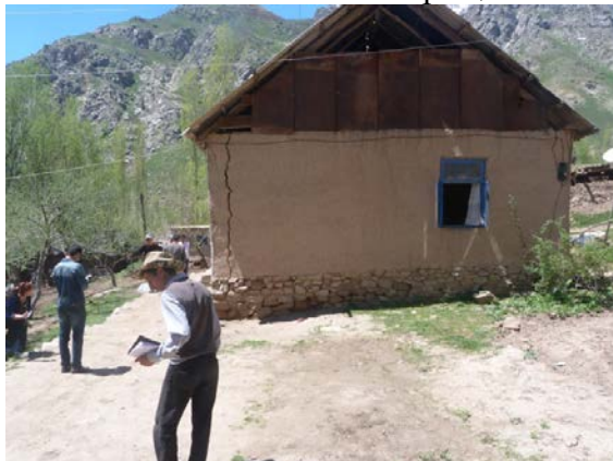
Фото 9-10. Кишлак Дувана (Таджикистан): сквозные трещины на стенах глинобитных домов.
