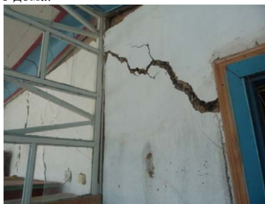
Фото 5-6. Кишлак Саргой (Таджикистан): обрушение части стены и сквозные трещины в стенах жилых домов.
