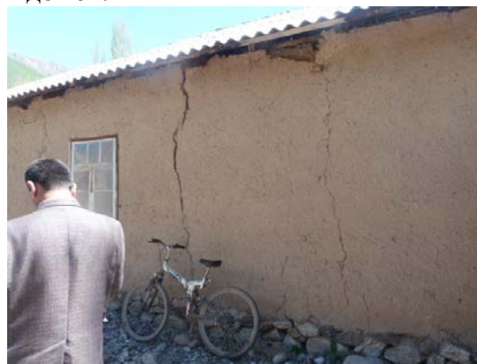
Фото 7-8. Кишлак Ачкалма (Таджикистан): обрушение части стены и сквозные
