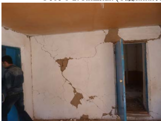
Фото 3-4. Кишлак Карамык (Таджикистан): сквозные трещины на стенах и углах жилого дома.
