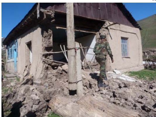
Фото 5-6. Кишлак Саргой (Таджикистан): обрушение части стены и сквозные трещины в стенах жилых домов.
