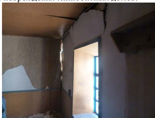
Фото 3-4. Кишлак Карамык (Таджикистан): сквозные трещины на стенах и углах жилого дома.
