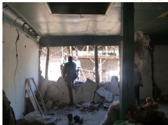
Фото 7-8. Кишлак Ачкалма (Таджикистан): обрушение части стены и сквозные
