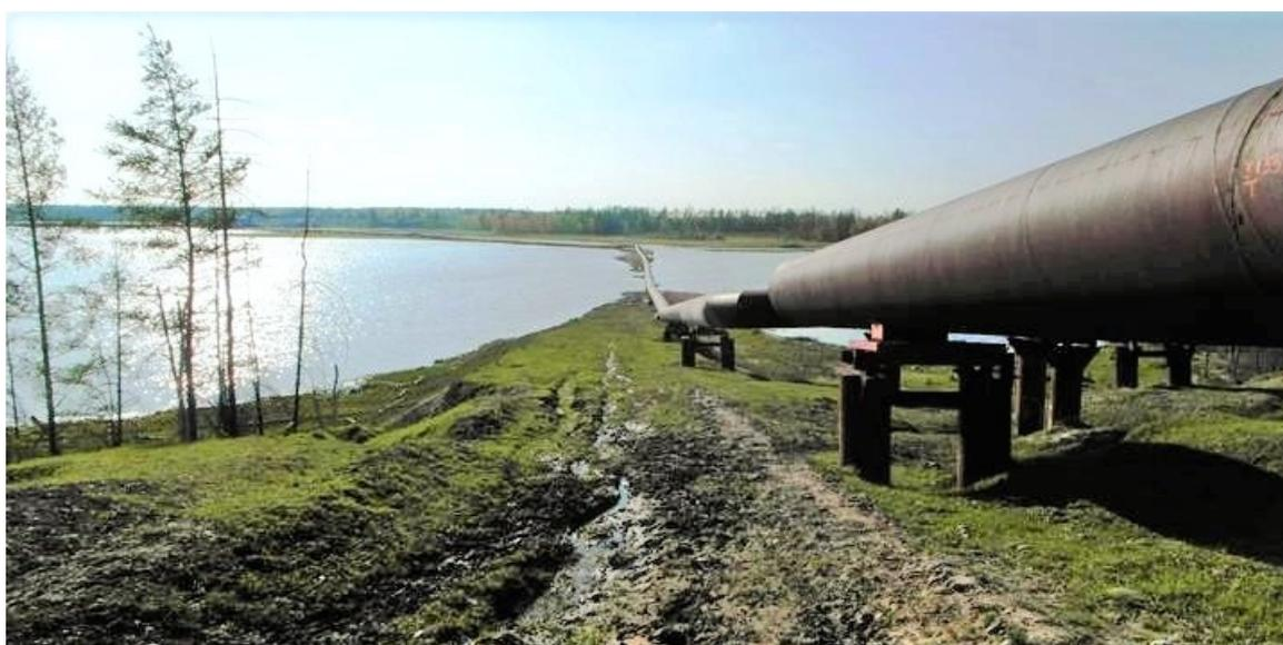
Рис. 6. Выпучивание опор магистрального водовода. Фото А. М. Сальва, 2018 г.
