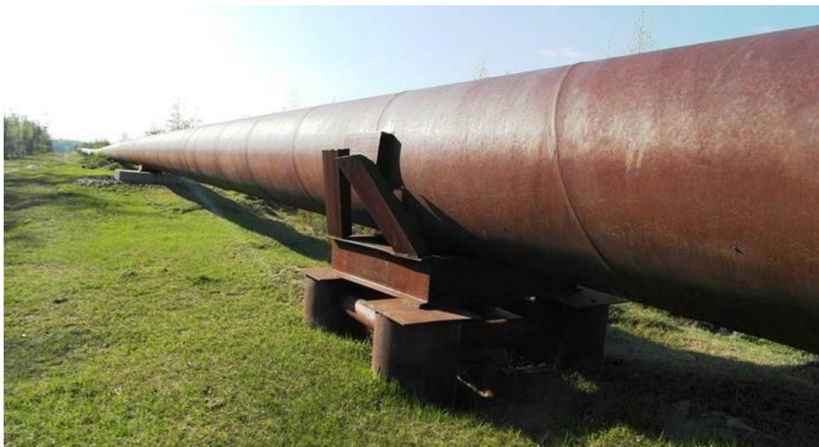
Рис. 8. Смещение водовода и разрыв двутавровых перегородок, Фото А. М. Сальва, 2018 г.
