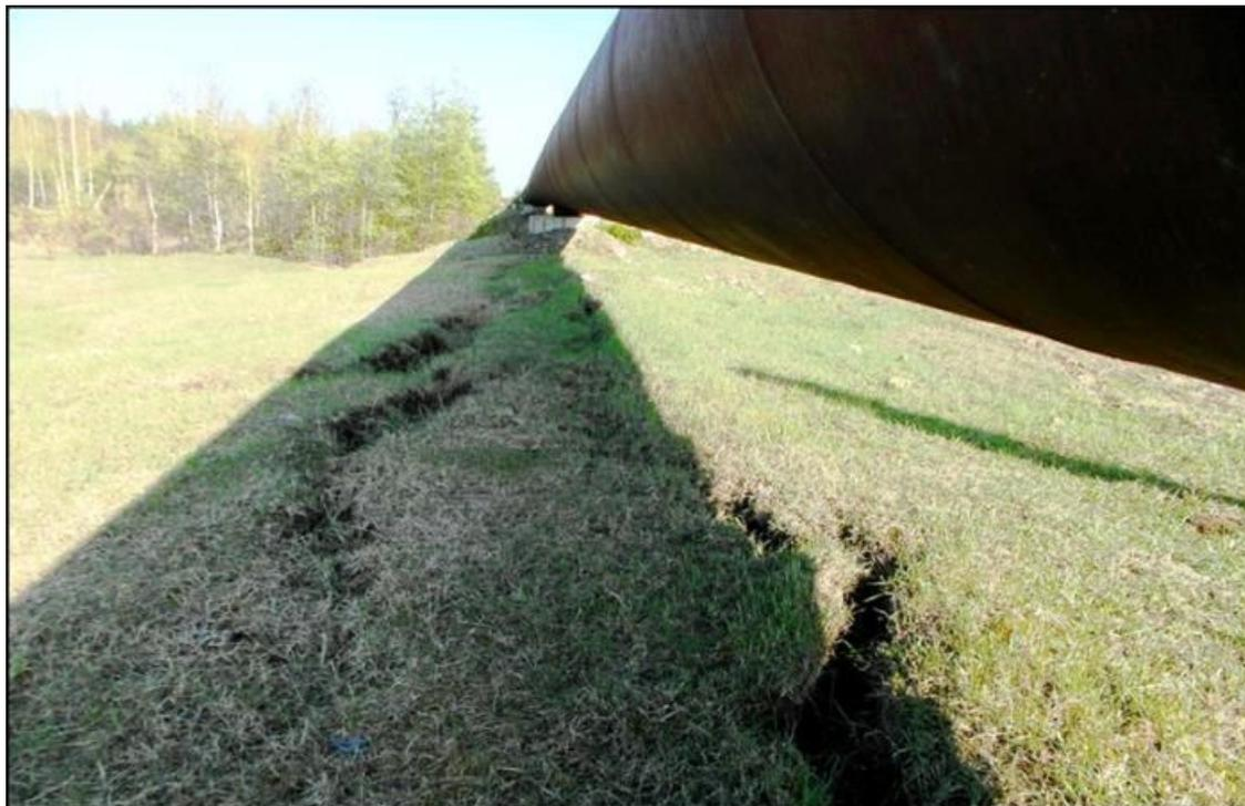
Рис. 7. Морозобойные трещины на трассе водовода. Фото А. М. Сальва, 2018 г.
