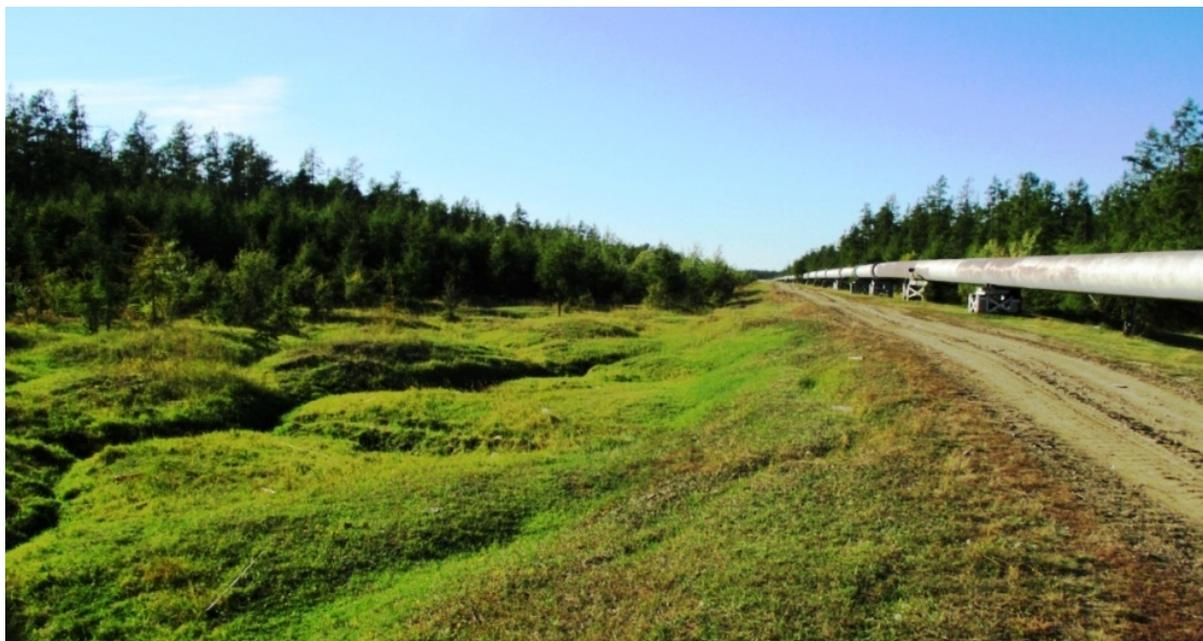
Рис. 5. Полигональный микрорельеф на трассе магистрального водовода «Лена – Туора Кюель – Татта» (п. Майя, вдхр. Мундуллах). Фото А. М. Сальва, 2016 г.
