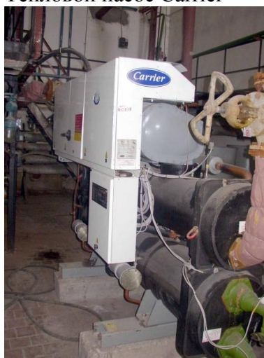
Рисунок 4 – Геотермальная установка и отапливаемое здание канализационной станции № 24 в д. Новый Двор Минского района.
