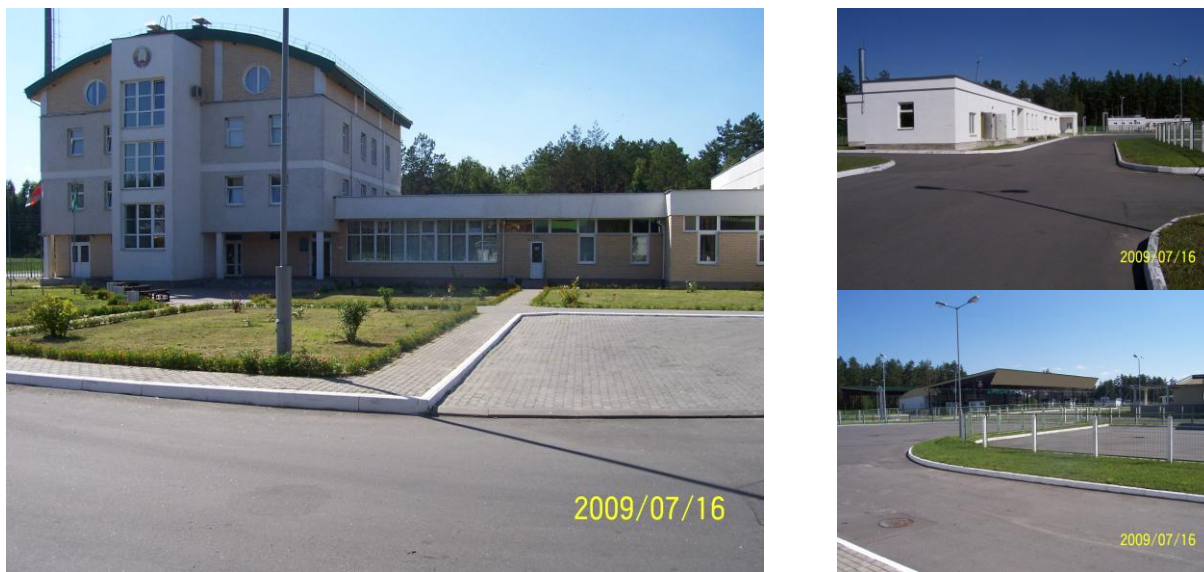
Рисунок 3 – Комплекс из 4-х зданий, отапливаемых теплонасосной геотермальной установкой на пограничном и таможенном переходе «Новая Рудня» на границе с Украиной.
