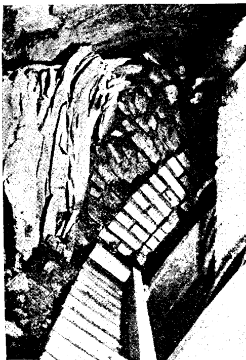
Фот. 9. Стреляние породы в верхней части Симпсонского туннеля во время кладки свода.
