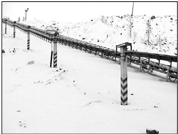
Рис.5.8. Дробильно-конвейерный комплекс фирмы "Man Takraf", рудник "Железный" Ковдорского ГОКа
