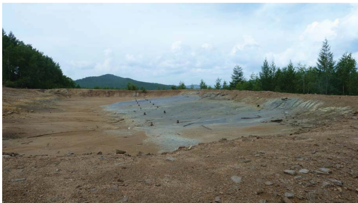
Рис. 3. Зброшенне (бoлее 20 лет) хвостохранилище молибденовой обогатительной фабрики
