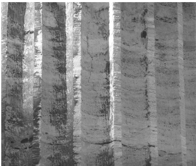
Рис. 2. Пористый слоистый туф и чёрные корки на нем. Южный портик. 2011 г.
