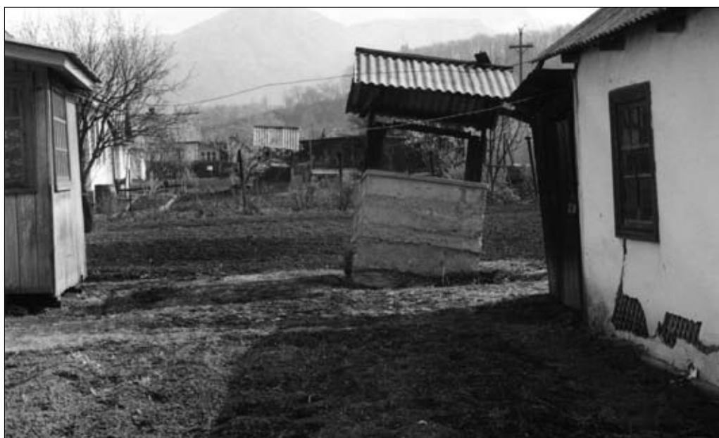
Рис. 5. Деформация колодцев над выработанным пространством. 2005 г. Фото И.А.Тарасенко
