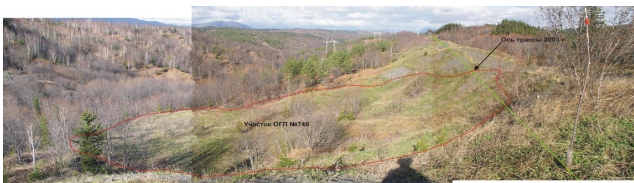
Рис. 1. Оползневый участок ОГП № 746 (обведен красной линией) на отрезке 378,2–378,3 км трассы нефтепровода (показана зеленой линией) по проекту «Сахалин-2» до начала строительства
