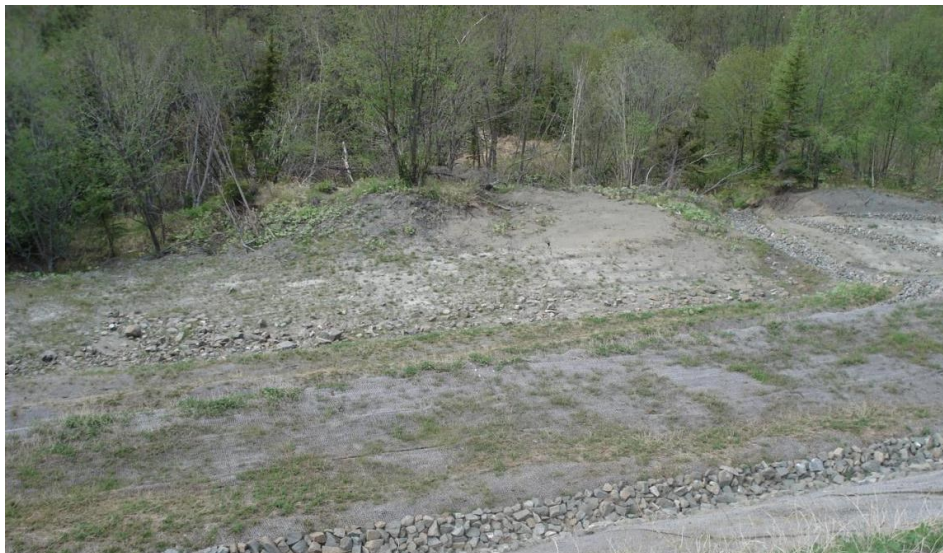
Рис. 2. Верхняя часть оползня после террасирования и создания дренажных поясов
