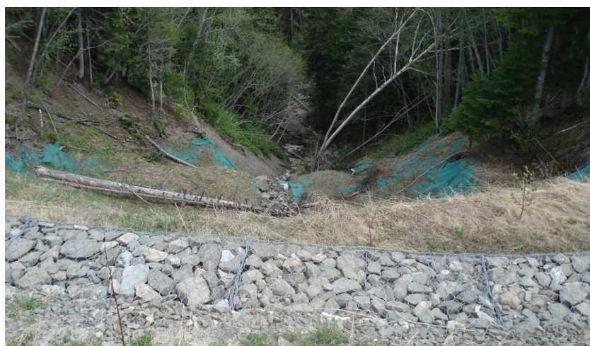
Рис. 4. Развитие активного эрозионного вреза на укрепленном склоне восточной экспозиции. Грунт сползает по долине ручья к реке Линек
