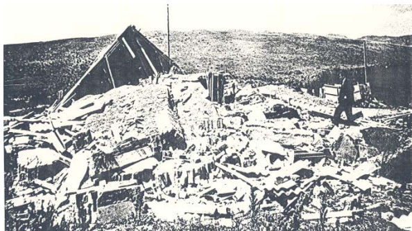
Фото 8. 8-ми-балльный эффект. Глинобитный дом в селе Толук [1, 2, 17, 18, 21].
