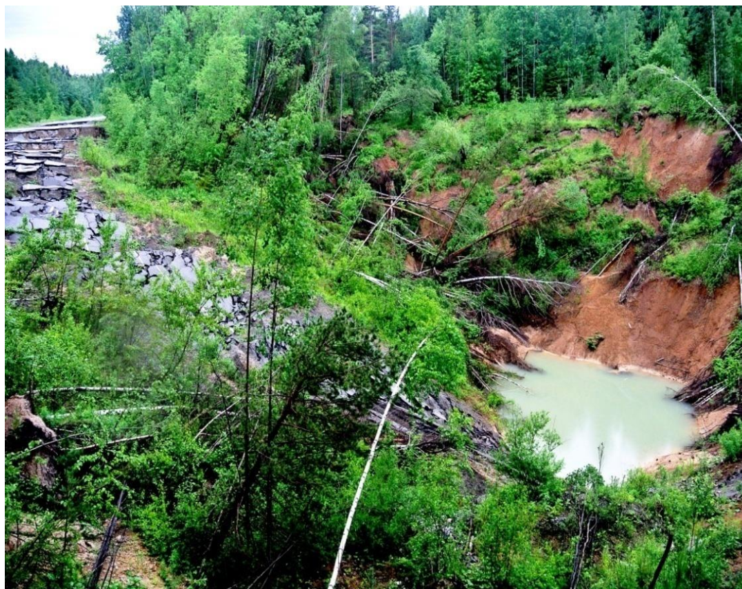
Рис.2 – Фактическое состояние зоны обрушения и бывшей автодороги
