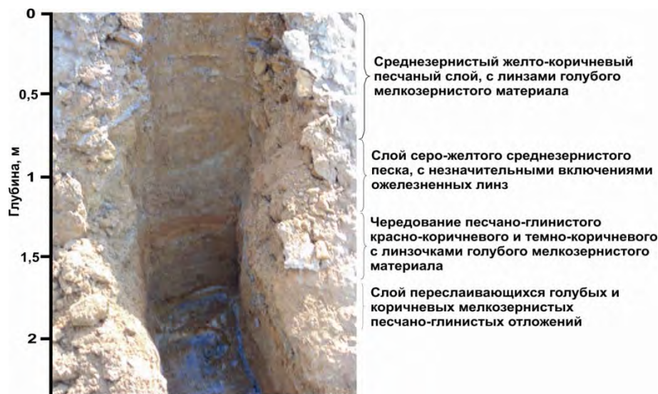
Рисунок 5.5 – Вертикальный разрез старого хвостохранилища КОФ. Шурф 3
